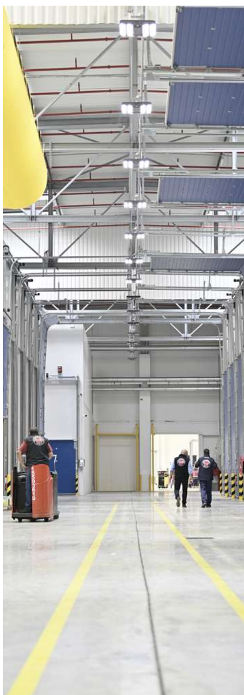
Entrepôt I1 - SIIM, Rungis, France
