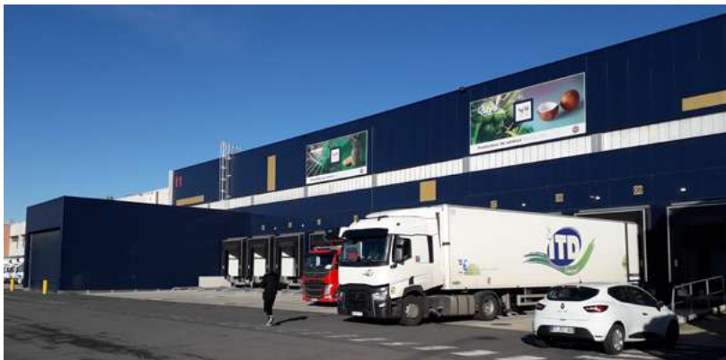
Bâtiment I1 - Plateforme de mûrissage et de conditionnement - SIIM, Rungis, France
